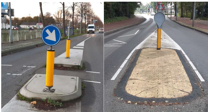
Figuur 3.13 Links: Wegonderbreking van beton. Rechts: Oplopend obstakel waar machines op kunnen rijden
